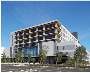
▲新築移転した鹿児島徳洲会病院。敷地面積は旧病院の4倍、駐車場は371台に。設備・医療機能がさらに充実
